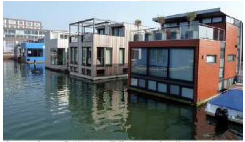
Les maisons flottantes d'IJburg, en banlieue d'Amsterdam pourront s'adapter à la montée des eaux.
