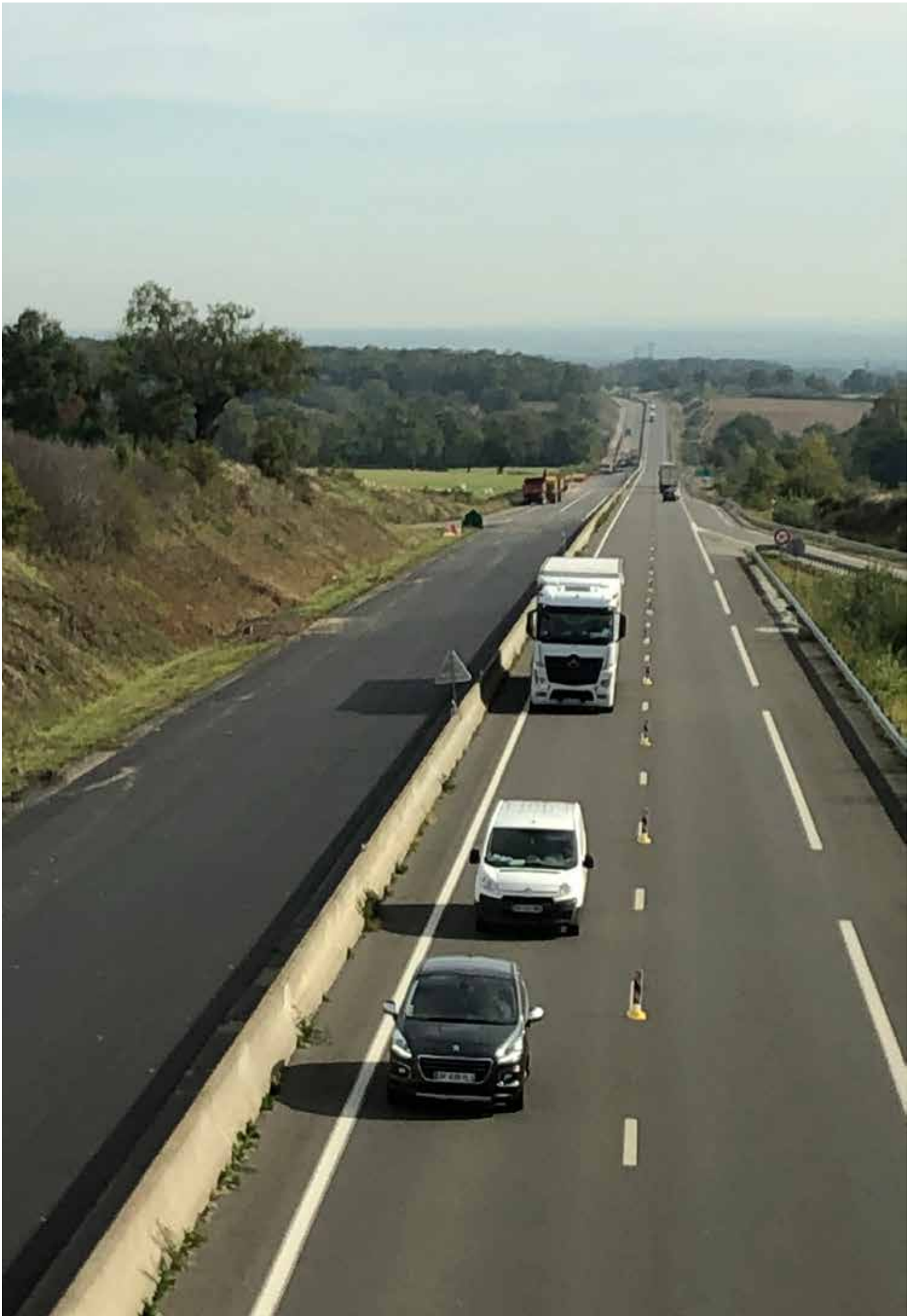
Le chantier de l'autoroute A79 au cœur du bocage bourbonnais. © Acadie
